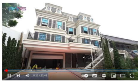
GOKIL! PERLUAS LAGI RUMAH BARU INAGITA BIKIN ROOFTOP UTK KAMAR RAFATHAR, RAFFI BANGUN TEMPAT KARAOKE
